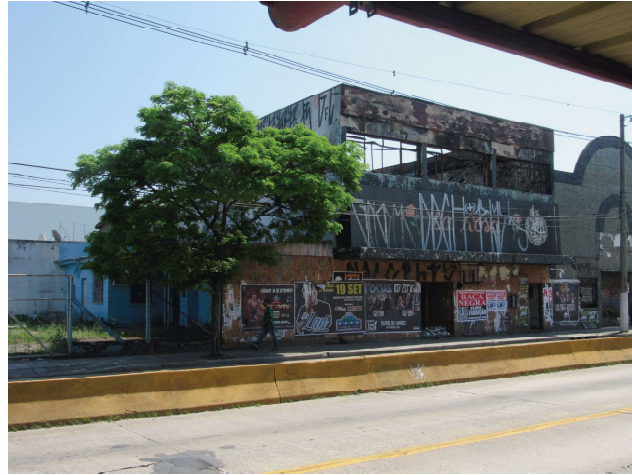
02. Casa noturna desativada incendiada no final de 2016. Av. Farrapos.
