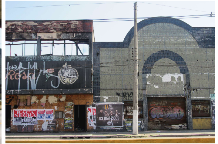
03. Interface entre a casa noturna e pavilhão desativado, ambos em ruínas. Av. Farrapos.
