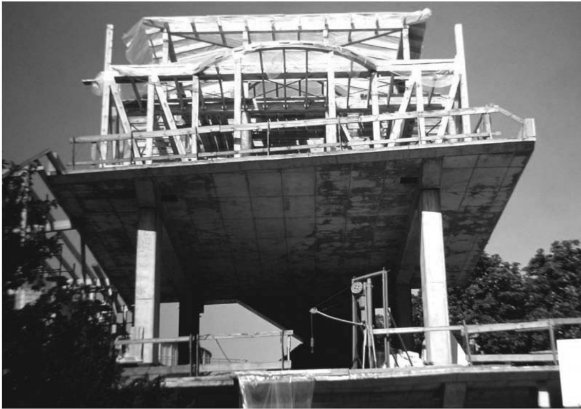
Imagem 54: Ökohaus em construção.
