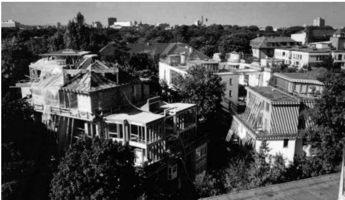
Imagem 55: Ökohaus em construção.
