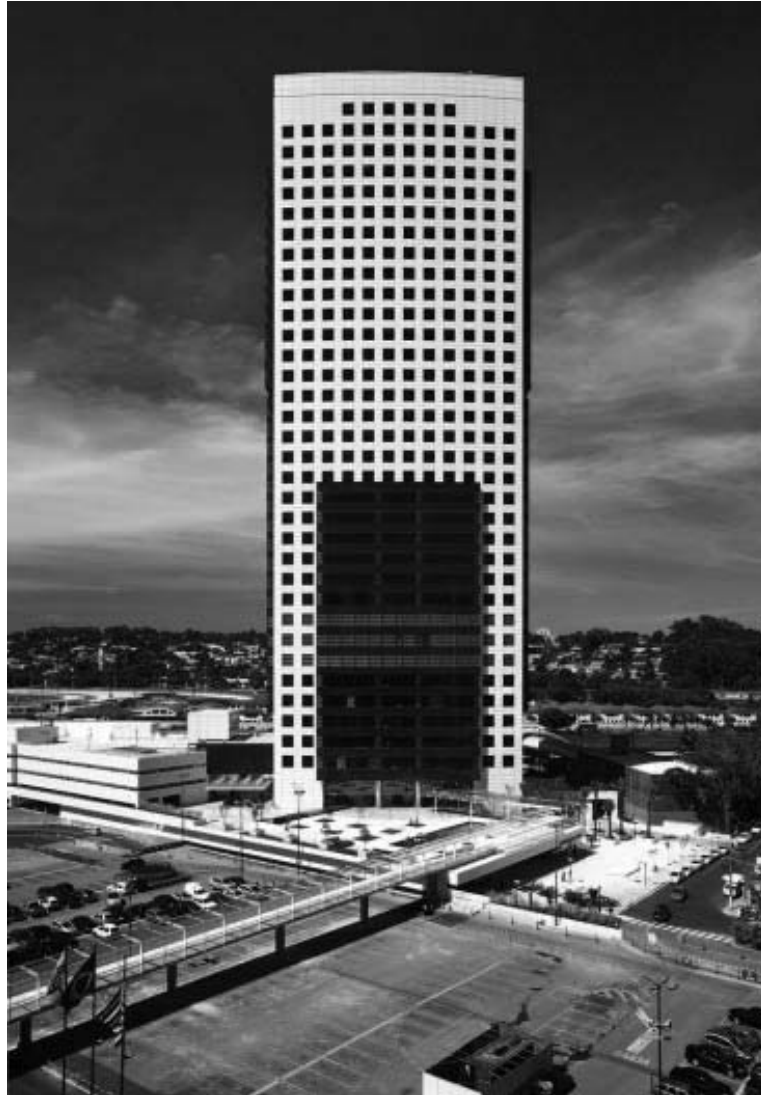
Imagem 30: Edifício Eldorado Business Tower, 2007, São Paulo. Aflalo & Gasperini Arquitetos. Primeiro Edifício da América Latina a receber certificado Platinum (Leed), a mais alta categoria de certificação eco-eficiente
