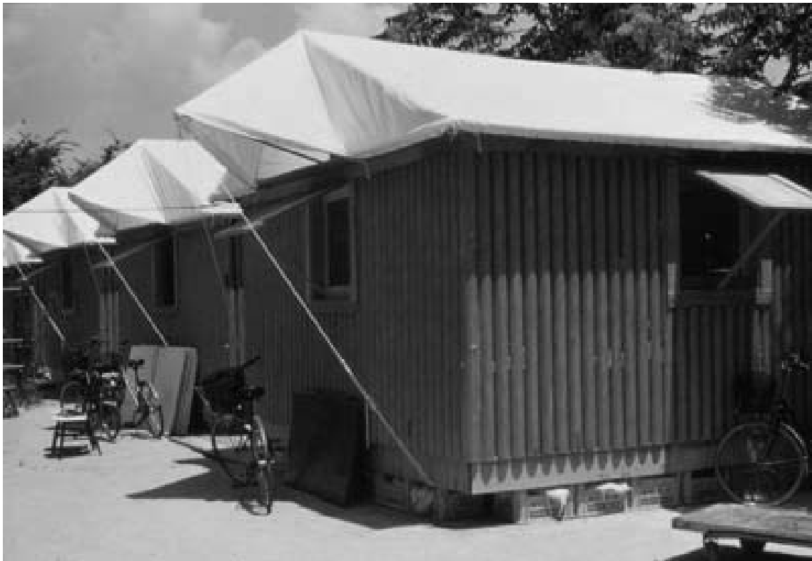
Imagem 51: Paper Log Houses - Kobe, Japão. 1995. Shigeru Ban.
