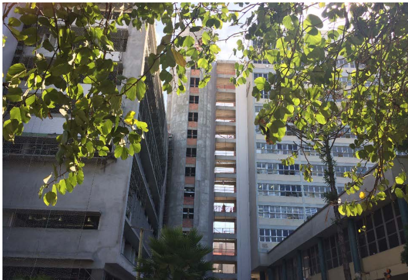
Figura 50: Ponto de conexão entre o Anexo I e o bloco existente (Fonte: autora, jan.2018)
