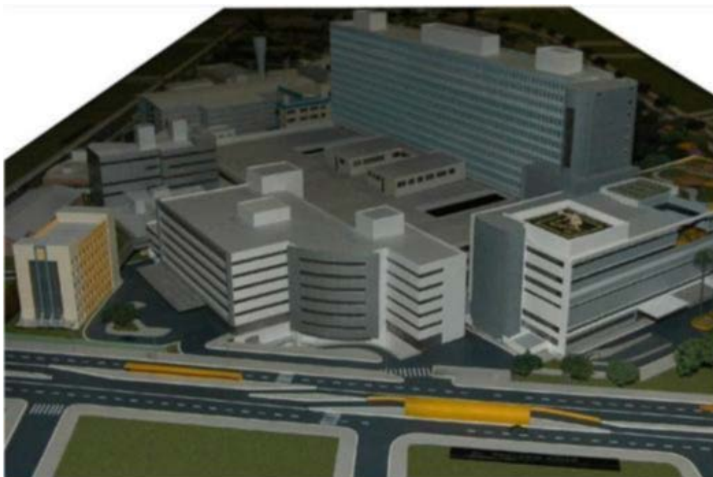
Figura 52: Vista parcial com a curvatura entre arestas do Anexo II, voltada para a Avenida Protásio Alves. (Fonte: material de divulgação do projeto de ampliação do HCPA)
