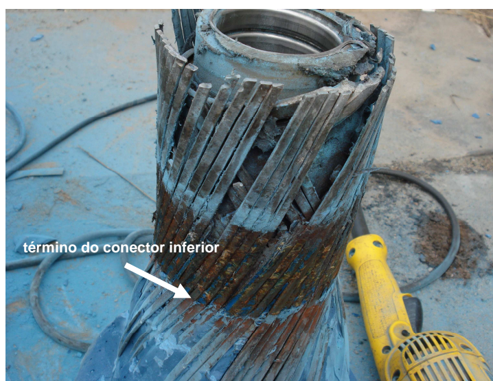
Figura 5.82 – Vista da região próxima ao conector inferior.
