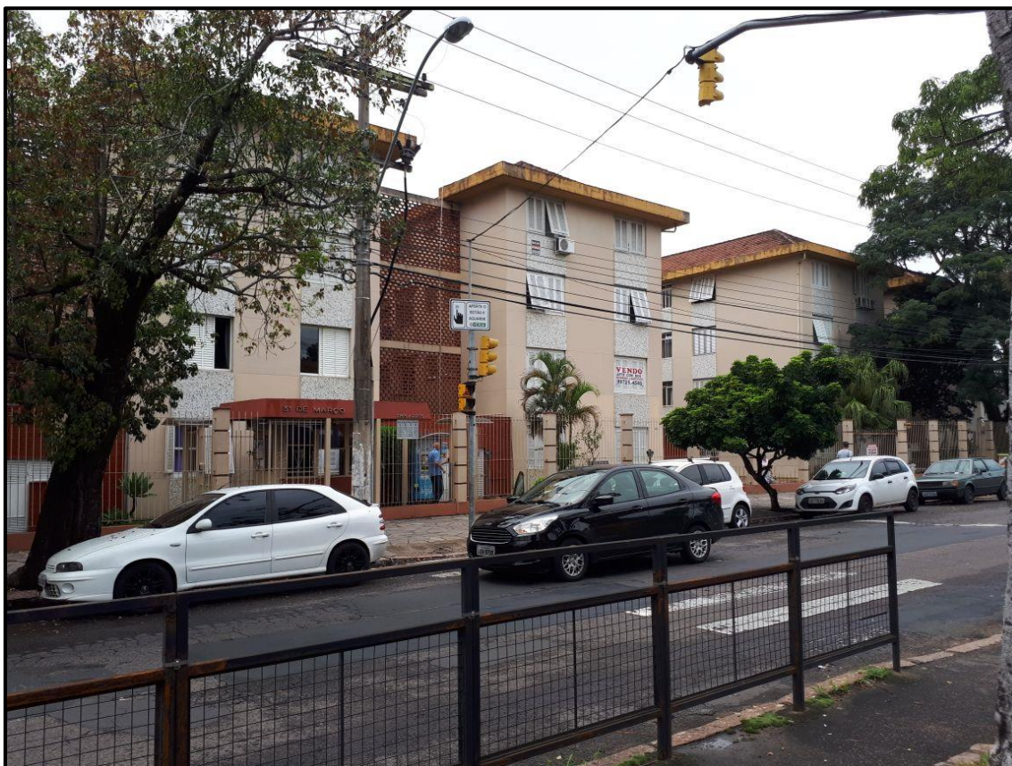
Figura 33 Conjunto Residencial 1º de Maio, limítrofe ao território do IAPI e moradia do Guilherme (Fonte: Arquivo Pessoal, 2017)
