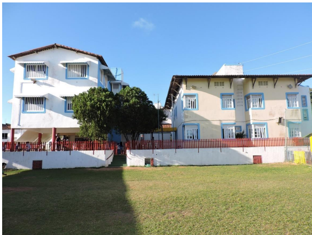
Figura 18: Vista Lateral do prédio da Casa Escola no Parque das Colinas
