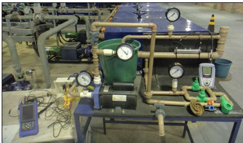
Figura 5. Resultado final da construção da bancada didática (Acervo LENHS, 2016).
