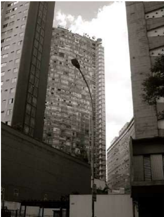
Figura 17 - Fachada Sul/ Sudeste Ed. Copan
