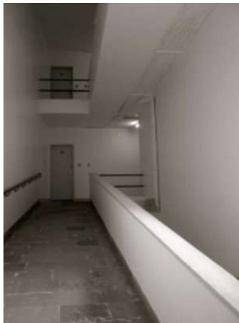
Figura 53 - Rampa de circulação no Bloco B do Edifício Copan
