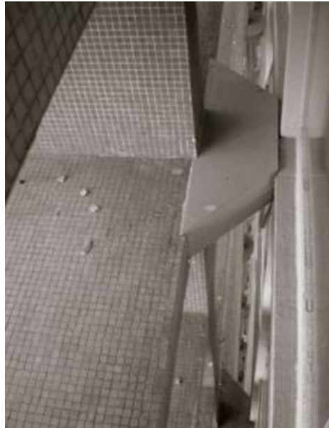
Figura 40 - Fixação dos brises soleils através do Console
