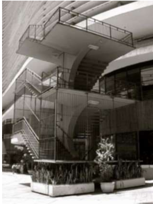
Figura 35 - Escada anexa ao Edifício Copan
