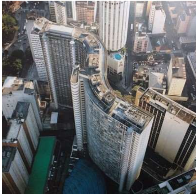
Figura 9 - Fachada de Fundos do Edifício Copan
