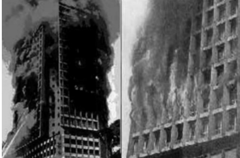
Figura 4 - Edifício Joelma em chamas
