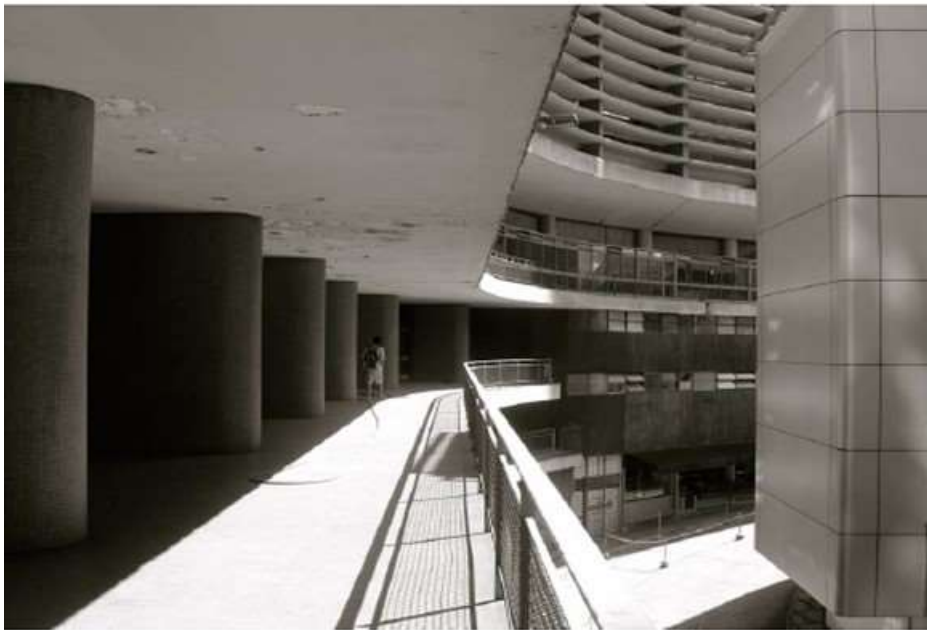
Figura 34 - Terraço do Edifício Copan
