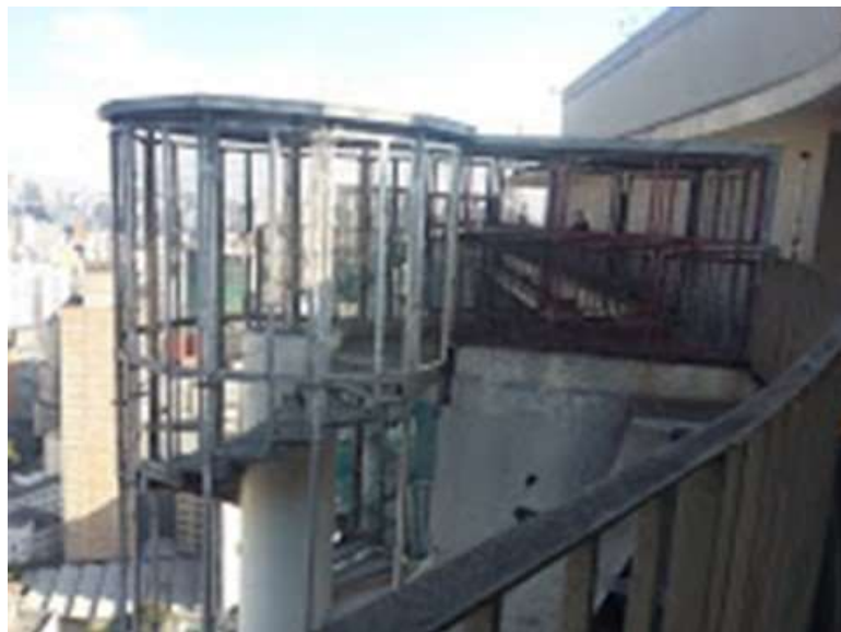
Figura 48 - Escada helicoidal vista da Cobertura do Edifício Copan
