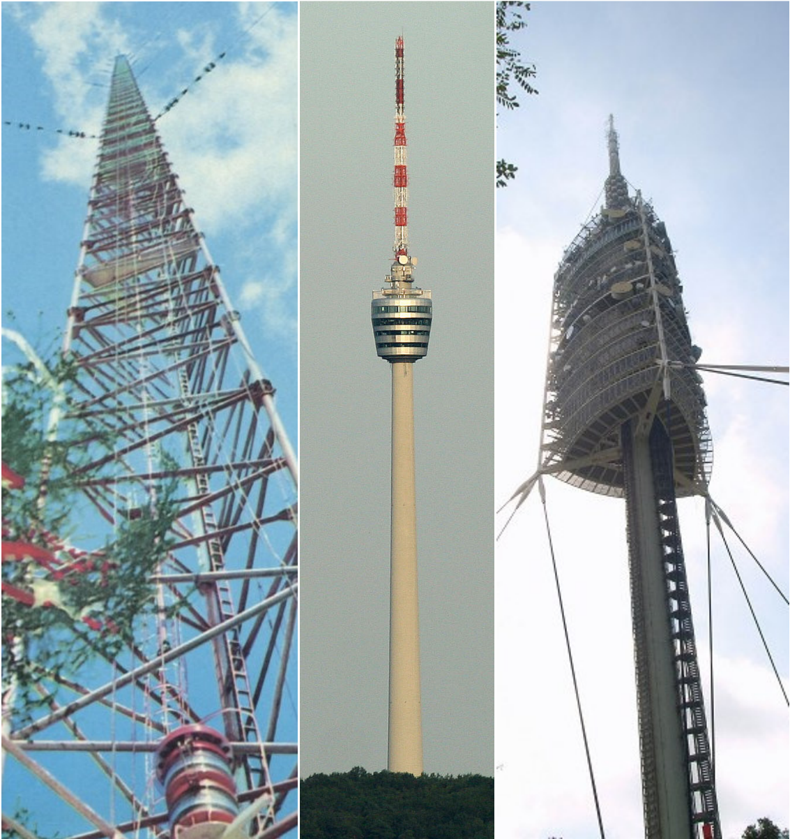
Figura 1 – Exemplo de: a) torre estaiada; b) torre autoportante (WIKIPEDIA, 2007b). c) torre mista (STRUCTURAE, 2008c).
