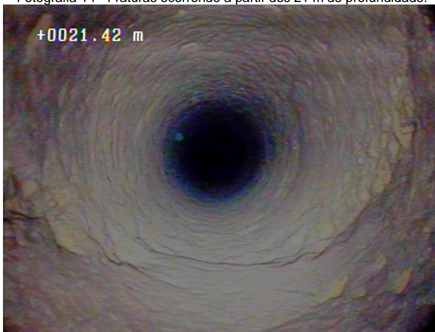
Fotografia 14 - Fraturas ocorrendo a partir dos 21 m de profundidade.
