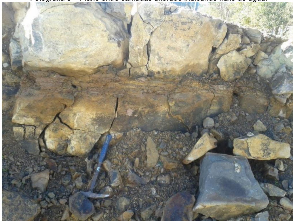
Fotografia 5 – Plano entre camadas alterado indicando fluxo de água.
