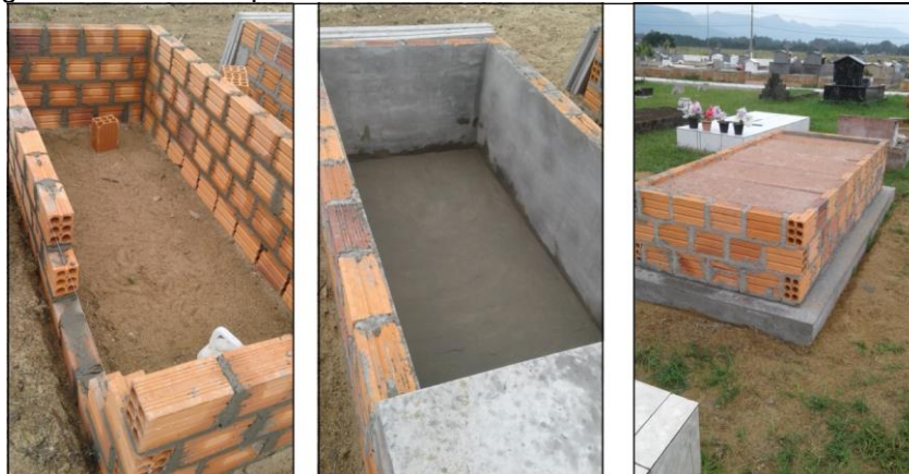
Figura 8: Fotos de sepulturas mostrando como são construídas atualmente.
