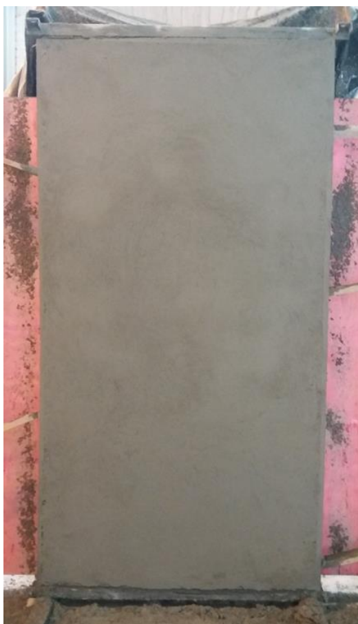
Figura 21 – Aspecto visual do revestimento acabado
