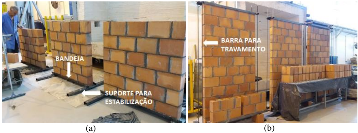
Figura 18 – Confeção das amostras: (a) assentamento das paredes com dimensões de norma e (b) amostras já assentadas
