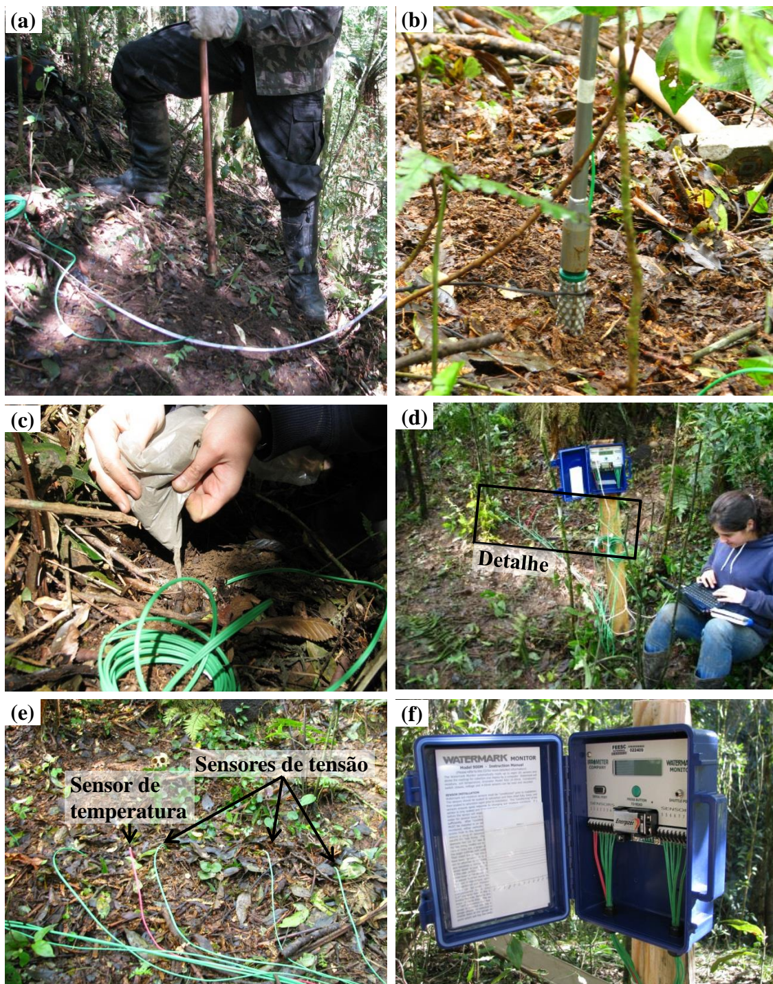
Figura 24 – Instalação do monitoramento de tensão da água no solo. (a) perfuração do solo com o trado apropriado; (b) inserção do sensor de tensão da água no solo; (c) preenchimento do furo onde foi inserido o sensor de tensão com solo do local; (d) programação do conjunto de monitoramento tensiométrico; (e) detalhe da figura (d) com indicação dos cabos dos sensores de tensão (verde) e temperatura (rosa); e (f) datalogger do conjunto de sensores de tensão e temperatura da água no solo.
