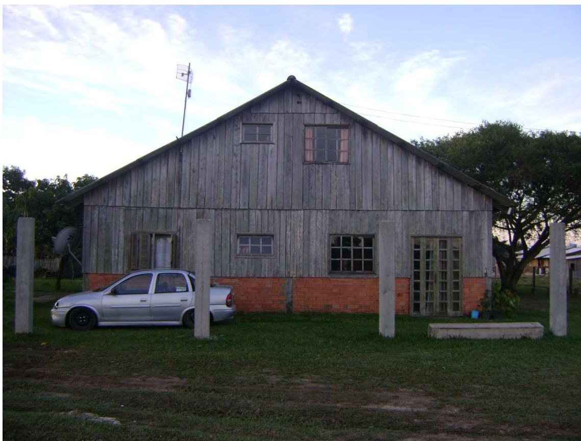
Figura 16: Galpão/casa de Lairton Borba
