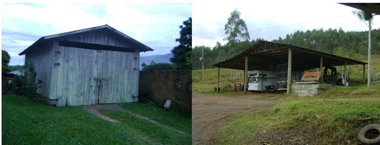
Figura 38: Galpão garagem de Rogério Schutz e Galpão garagem de Gilnei Neubert
