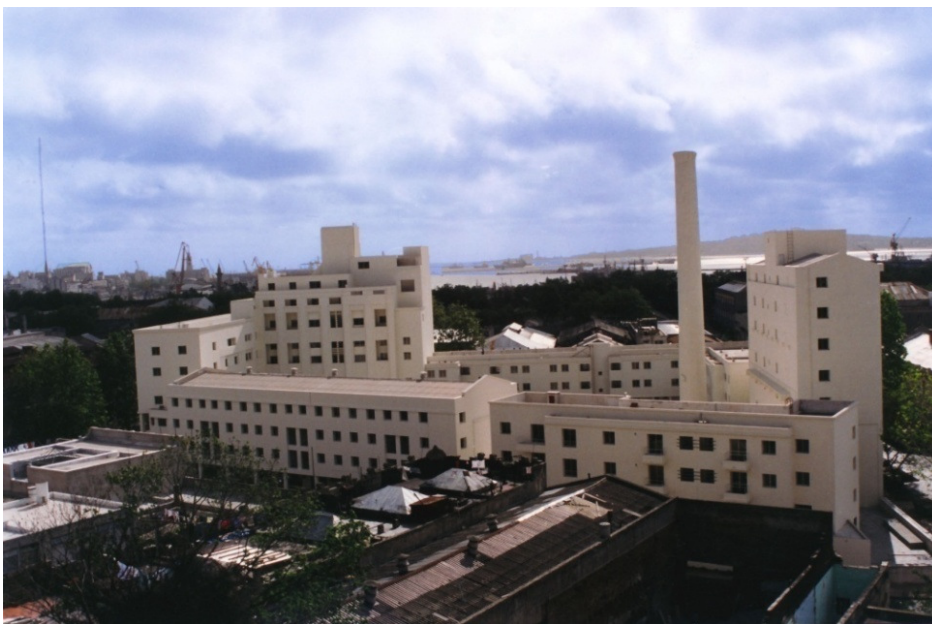
Fig. nº.34 - Conjunto Cuareim - Vista geral do conjunto com o porto ao fundo
