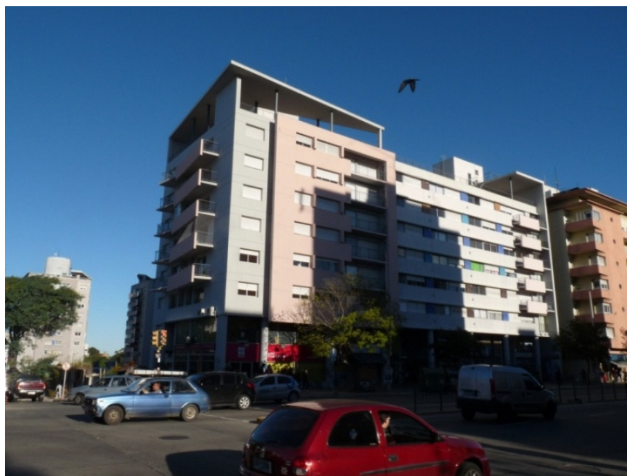
Fig. nº. 35 - Conjunto Ciudad de las Tres Cruces - Av. 8 de Octubre
