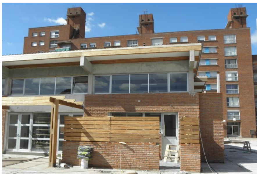
Fig. nº. 33 - Conjunto CUTCSA XIV - Vista do Pátio Interno
