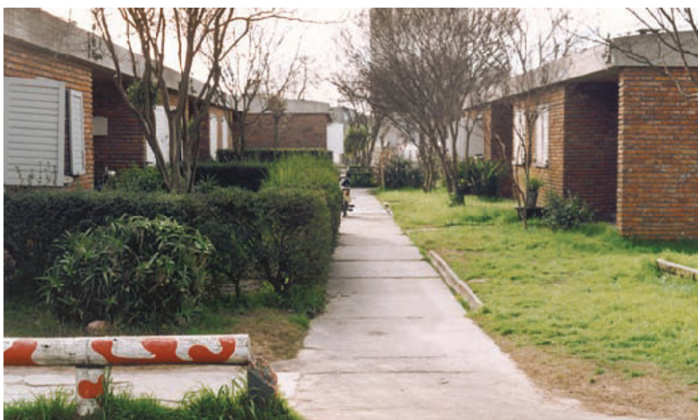
Fig. nº. 26 - Vista da configuração das unidades em relação à rua interna de pedestres
