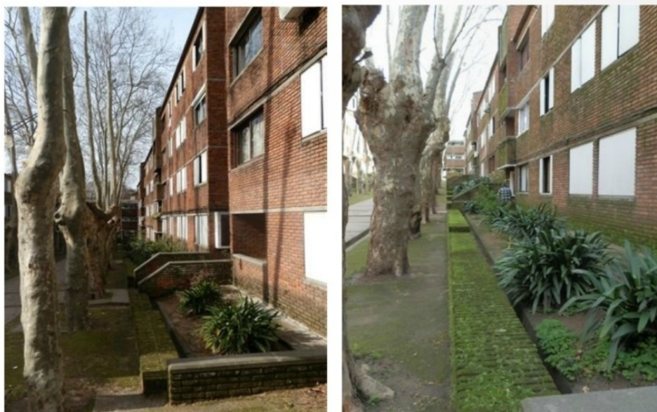
Fig. nº. 31 - Conjunto CUTCSA IV - Vistas da Rua Corredor
