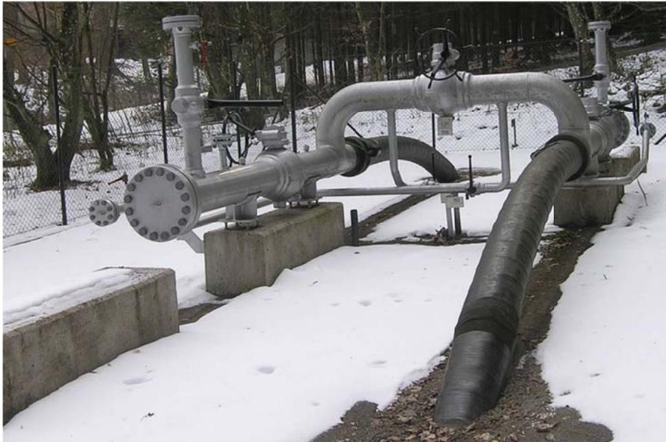
Figura 2.3 - Lanzadera y distribuidor.
