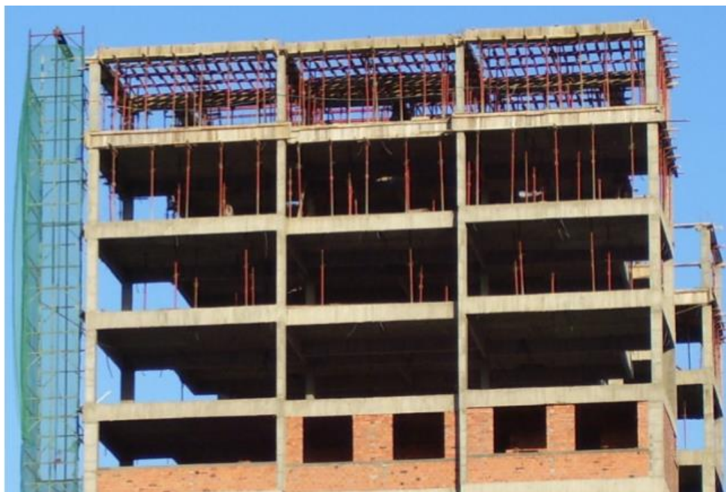
Figura 2.2 – Sistema de escoramento típico empregado em edifícios residenciais.
