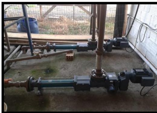
Figura 5.2 Bombas tipo helicoidal de alimentação do UASB e do RAH
