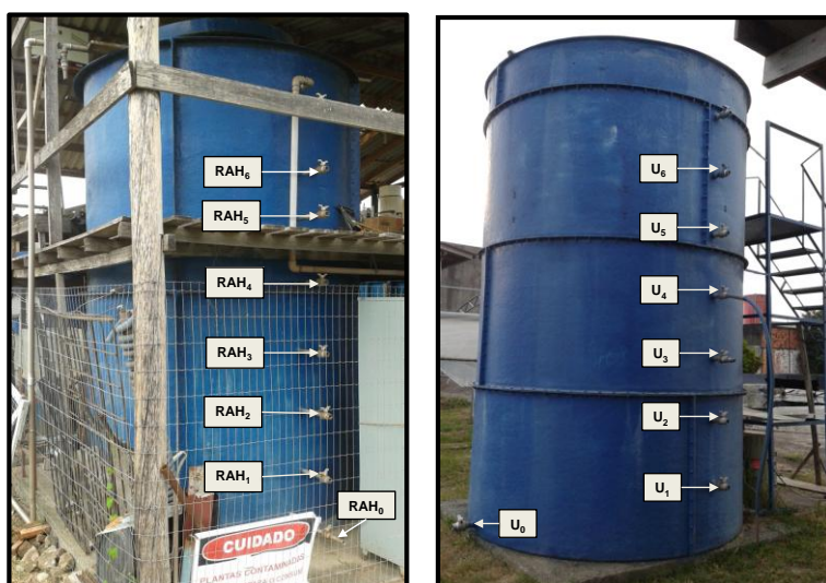
Figura 5. 7 Pontos de amostragem de lodo ao longo do reator UASB e do RAH
