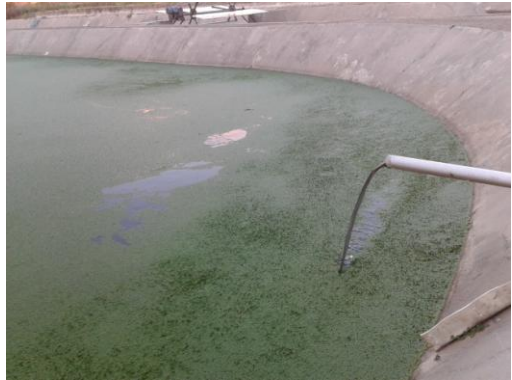
Perda de lodo no efluente do UASB
