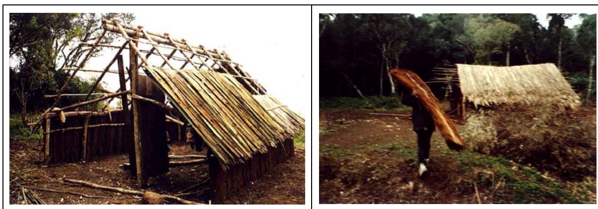
Figura 44: montagem da cobertura e das paredes. Fotos: Paulo Roberto de Fernandes (2003).
