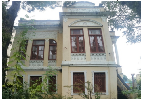
Figura 28: FACHADA SE. Fonte: Acervo pessoal.
