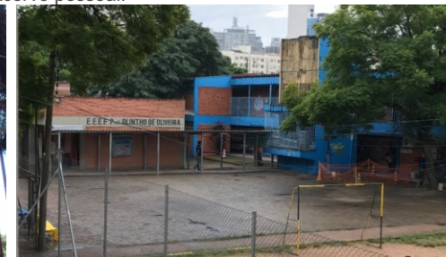
Figura 03: REFEITÓRIO E SALAS. Fonte: Acervo pessoal.
