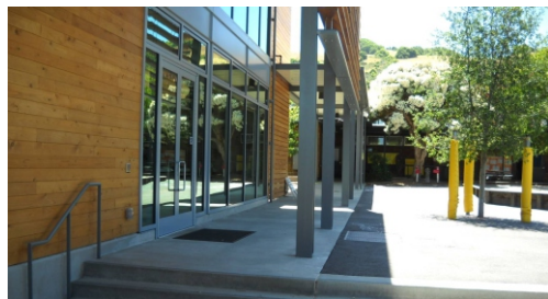
Figura 49: FACHADA ESCOLA. Fonte: Aasarchitecture.
