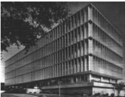
Figura 48 – Exemplo de caixa de brise. Pan América Seguros: Skidmore, Owings & Merrill, New Orleans. Fonte: OLGAY & OLGAY, 1957.
