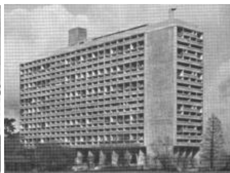
Figura 54 – Exemplo de brise formando loggia . Unidade Habitacional: Le Corbusier, 1947, Marselha. Fonte: BOESIGER & GIRSBERGER, 1994.
