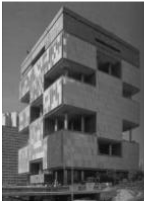
Figura 57 – Exemplo de brise como principal expressão formal. Edifício sede da Petrobrás: Assad, Gandolfi, Sanchotene, Forte Neto e de Castro, 1967, Rio de Janeiro. Fonte: FINESTRA 21/2000.
