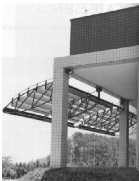
Figura 46 – Exemplo de brise adicionado. IFF Aromas: Edmundo Musa, 1998, Taubaté. Fonte PROJETO/DESIGN 246.
