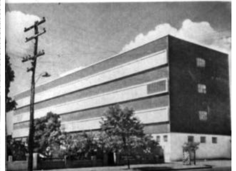
VISTA GERAL NA ÉPOCA DA CONSTRUÇÃO
