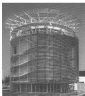
Figura 5 - Brise-soleil giratório do edifício da Siemens na Expo 92, em Sevilha. Fonte: PARÍCIO, 1999.
