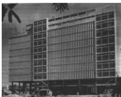
Figura 53 – Exemplo de brise formando painel. Edifício IRB: MMM Roberto, 1941. Rio de Janeiro. Fonte: OLGAY & OLGAY, 1957.
