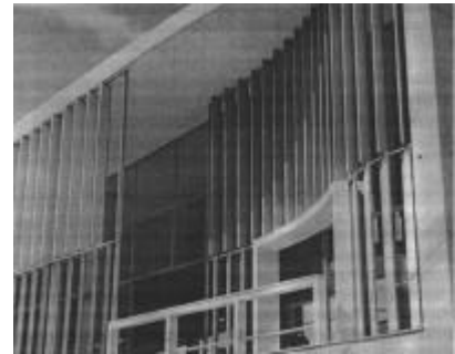
Figura 50 – Exemplo de brise recuado. Iate Club da Pampulha: Oscar Niemeyer, 1942, Belo Horizonte. Fonte: OLGAY & OLGAY, 1957.
