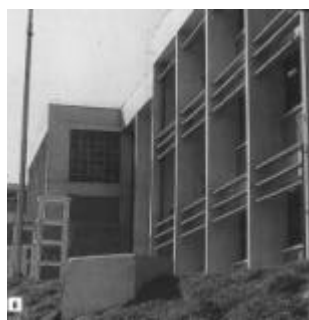
Figura 49 – Exemplo de brise saliente. Escola Parque Piratininga: Beno Perelmutter, 1997, Itaquaquecetuba. Fonte: PROJETO/DESIGN 236.
