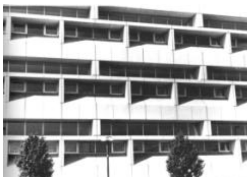
Figura 51 – Exemplo de leitura em linha proporcionada por um lighshelf. Office Power Building: Caudill Rowlett Scott, 1986, Chattanooga.
