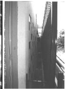
VISTA DO COBOGÓ
