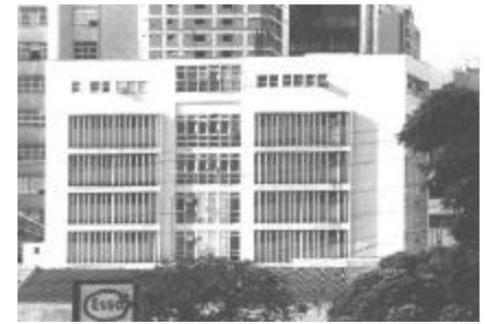
VISTA GERAL SUL
