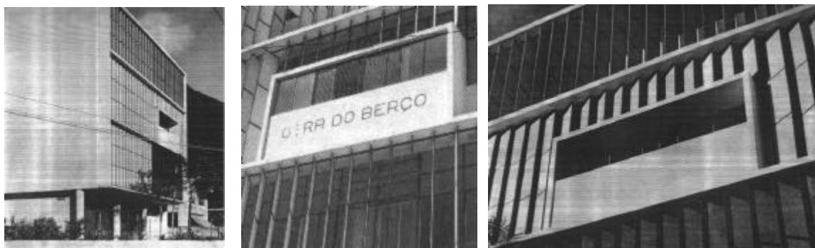
Figura 32 – Brise-soleil vertical móvel da Obra do Berço. Niemeyer, 1937. Fonte: OLGAY & OLGAY, 1957; XAVIER, 1991.
