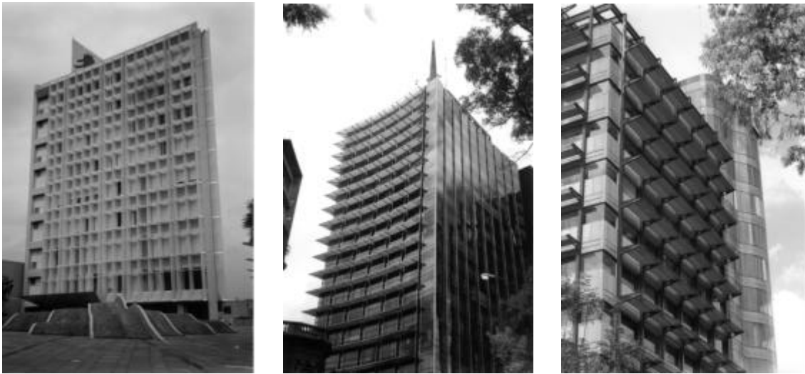
Figura 47 – Exemplos de brises leves adicionados ao conjunto. Arquitetura contemporânea do México, 2000. Fonte: Acervo do autor.
