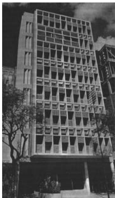
Figura 45– Exemplo de brise integrado ao todo. Edifício Copacabana: MMM Roberto, 1945, Rio de Janeiro. Fonte: OLGYA & OLGAY, 1957.
