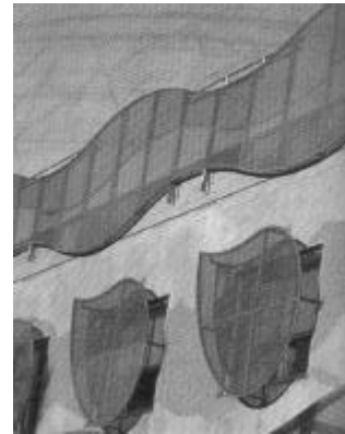
Figura 59 – Exemplo de brise com painel metálico vazado. Centro Cultural Shonandai: Itsuko Hasegawa 1989, Shonandai. Fonte: MEYHÖFER, 1994.
