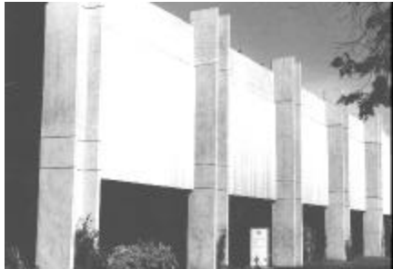
VISTA GERAL BLOCO DE TREINAMENTO
