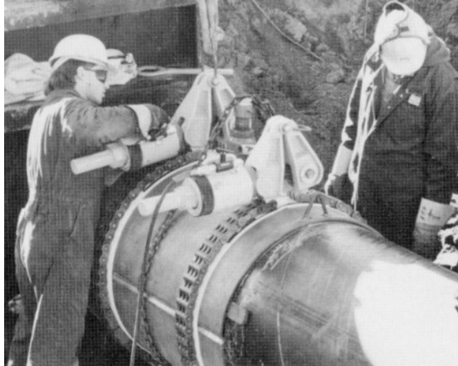
Figura 8: Reparo comercial executado pela empresa PLP.
