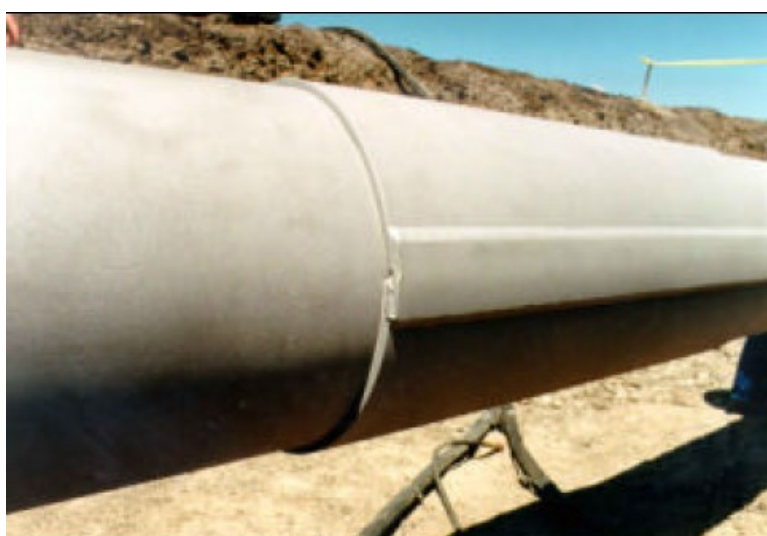
Figura 7: Reparo comercial executado pela empresa PetroSleeve
