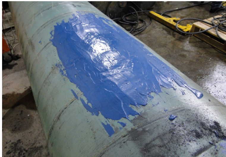
Figura 32: Aplicação da resina na região defeituosa do corpo de prova
