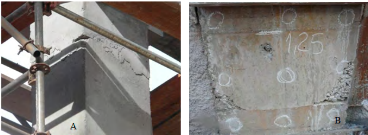
Figura 6. Detalhe da junta de concretagem do na parte superior do Pilar 7, (A e B)
