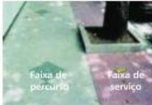
O piso deve ser antiderrapante, regular e contínuo, sem degrau e ter inclinação em direção ao meio fio, não superior a 2%.
