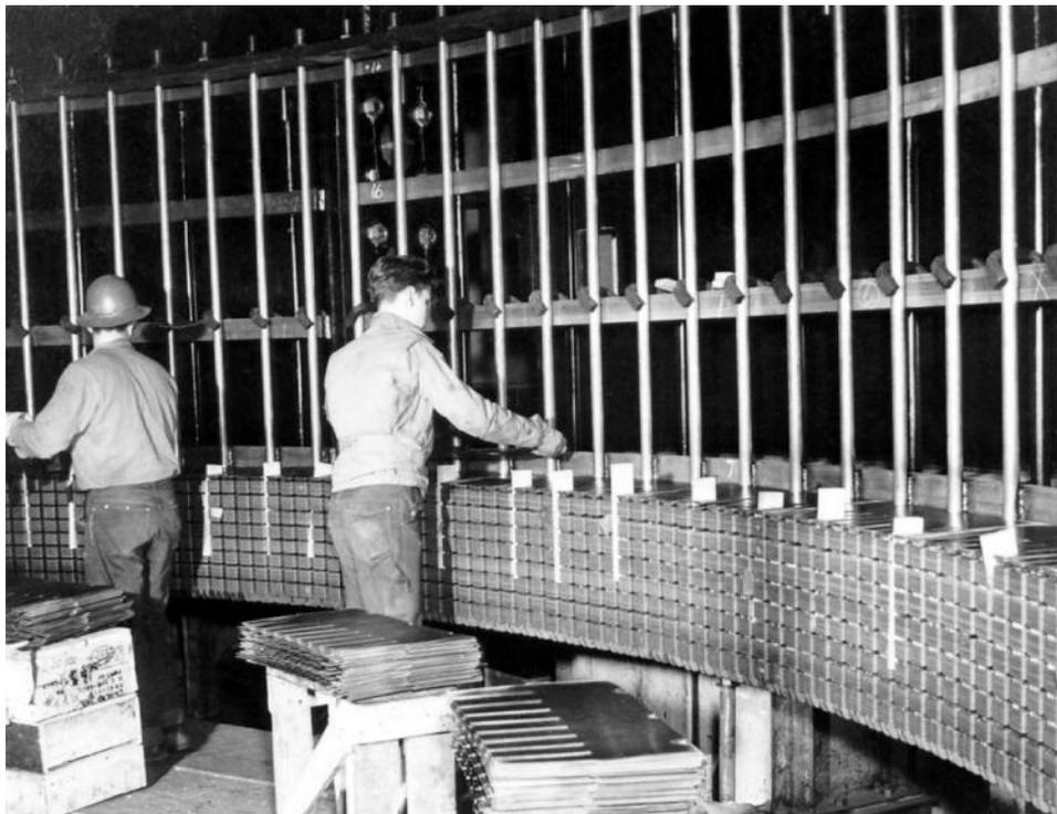
**Figura 11** – Estrutura de chapas laminadas em um motor [1]. Processo de fabricação de um grande estator.
