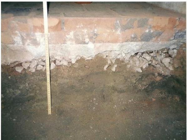
FIGURAS A05 e A06: Imagem do *poço-teste* escavado em 2002 para a colocação elevador de acessibilidade no Solar e do perfil estratigráfico da parede Leste (em destaque), respectivamente.
