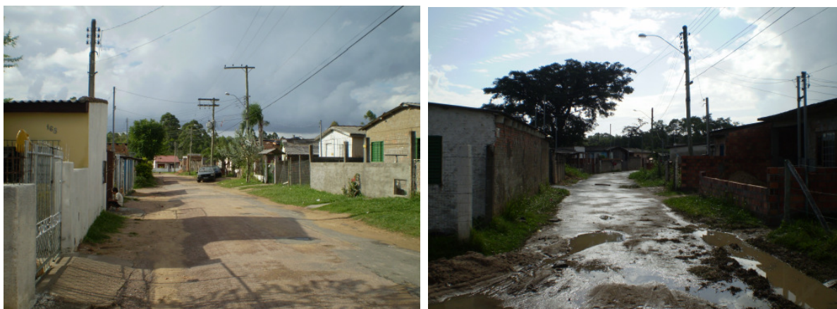
Figuras 30 e 31 - Vila Beco do Bita. Fonte: Nola Gamalho, mar/2008
