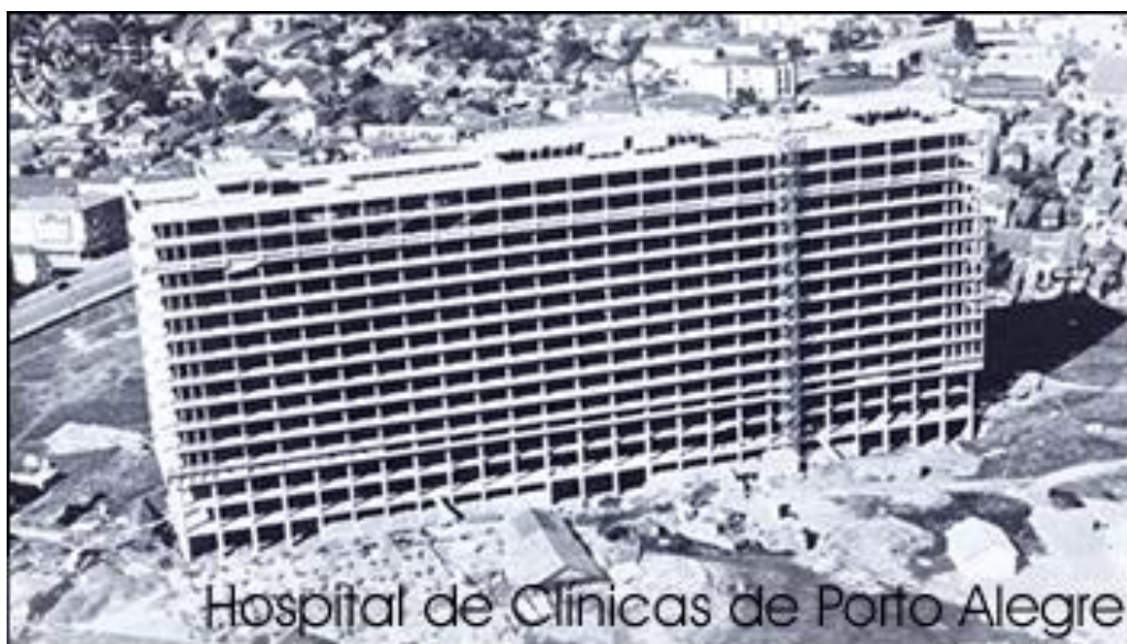
Figura 8 - Hospital de Clínicas de Porto Alegre em fase final de construção, 1970
