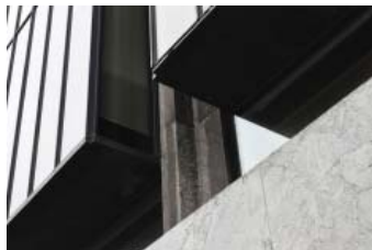
Fig. 307 Banco Nacional da Dinamarca, 1956, Copenhague. Arquiteto: Arne Jacobsen. Detalhe da fachada.
