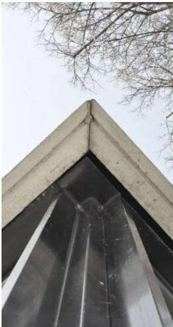
Fig. 49 Detalhe da estrutura.
