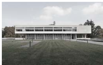
Fig. 160 Escola Freudenberg, em Zurique. Foto do edifício.
