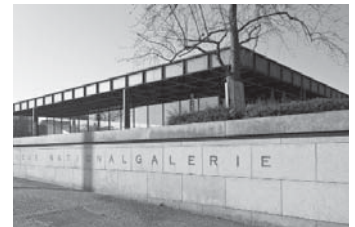
Fig. 312 Galeria Nacional de Berlin, 1968, Alemanha. Arquiteto: Mies van der Rohe. Vista externa.
