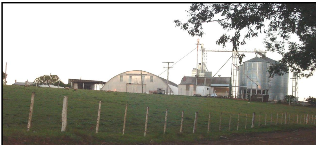
Figura 24 – Silo metálico para armazenamento da produção agrícola em estabelecimento agropecuário no município Júlio de Castilhos/RS.
