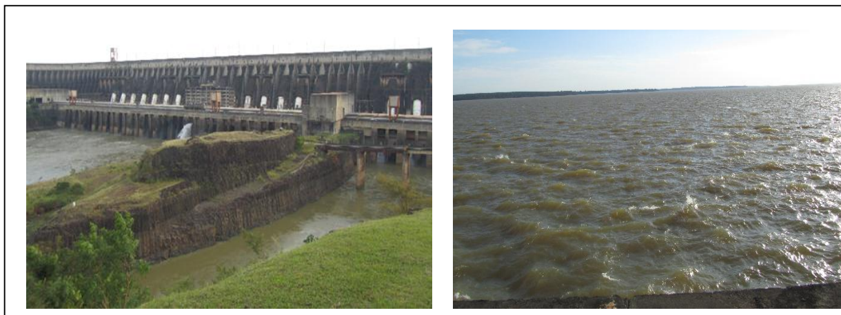
Figura 4 - Vertedouro e reservatório de Itaipu Binacional
