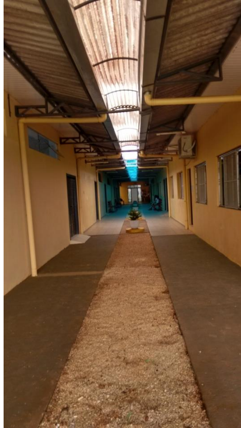
Figura 11 - Corredor coberto que liga os blocos A e B.
