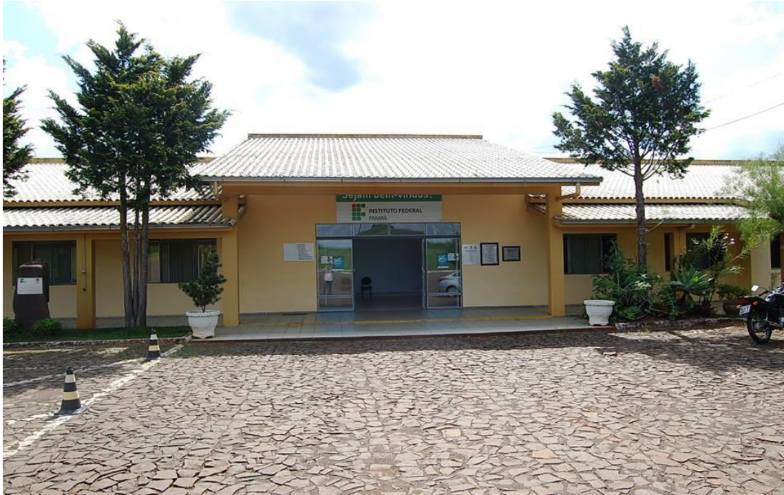
Figura 7 - Parte da fachada do bloco Administrativo do IFPR – Campus Avançado Barracão (entrada principal).
