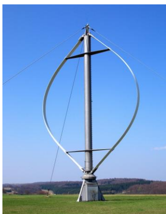
A: Turbina eólica de eixo vertical tipo Darrieus.
