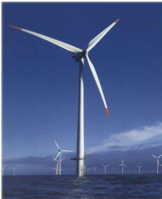
Figura 6: Turbina eólica de eixo horizontal.
