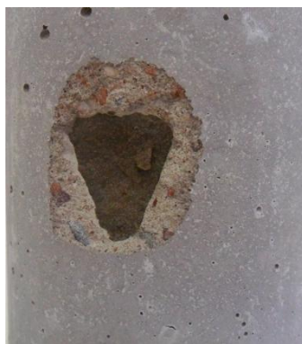
Figura 5.48 – Lascamento superficial do concreto com CCA amorfa aquecido rapidamente até 600°C
