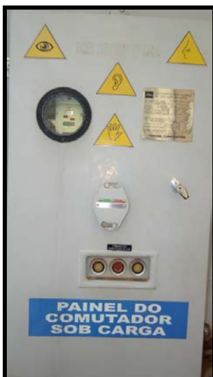
Figura 26 – Detalhes do painel do comutador sob carga
