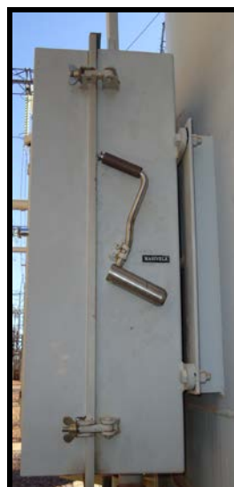
Figura 26 – Detalhes do painel do comutador sob carga
