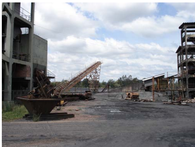
Figura 14: Pátio da Mina do Leão I.
