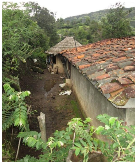
Figura 14: Vivienda de Samuel Morales, al fondo la casa antigua.
