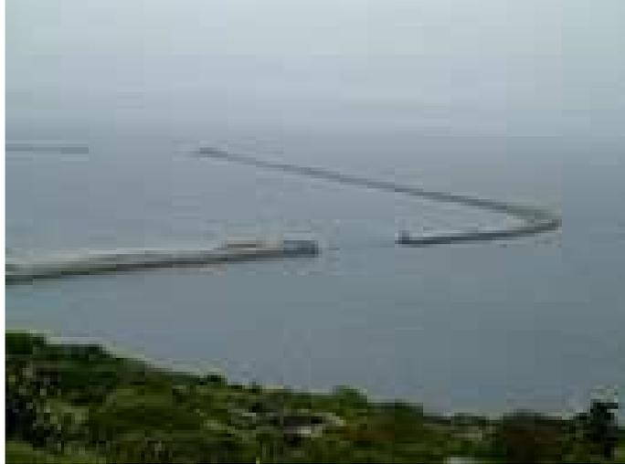
Figura 1.4: A imagem mostra três dos quatro quebra-mares formando o ancoradouro Portland (*Portland Harbour*) [28].
