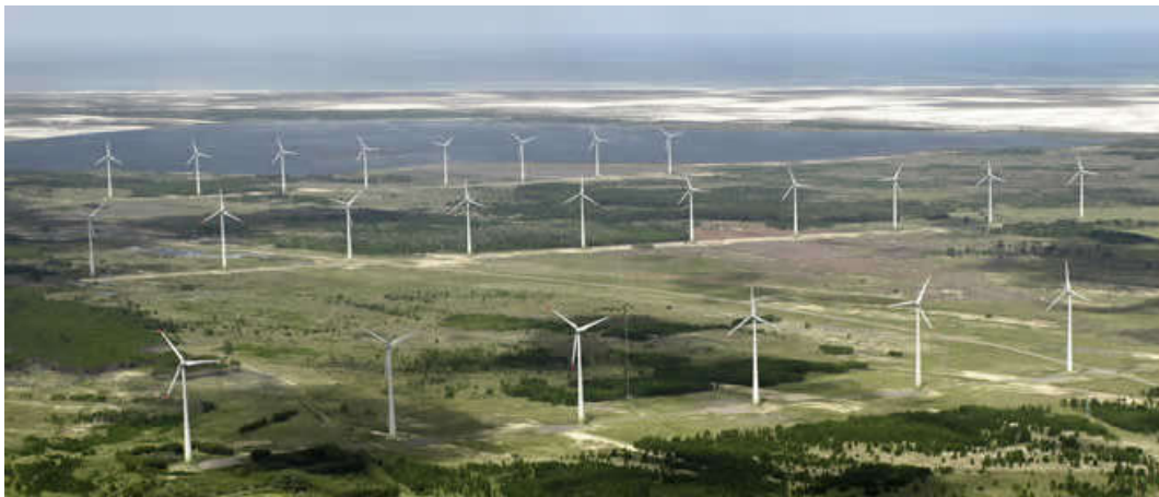
Figura 08: Parque Eólico de Osório – Osório/ RS. Fonte: ENERFIN, 2016.
