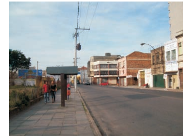
fig.03 Rua Voluntários da Pátria ruas abandonadas nos fins de semana
