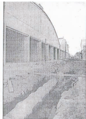
Obras no DC: reforma total nas instalações da Renner
