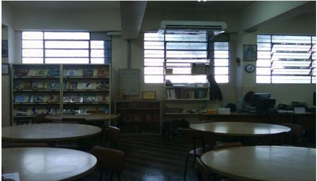
Foto3 – Janelas antes da Reforma
