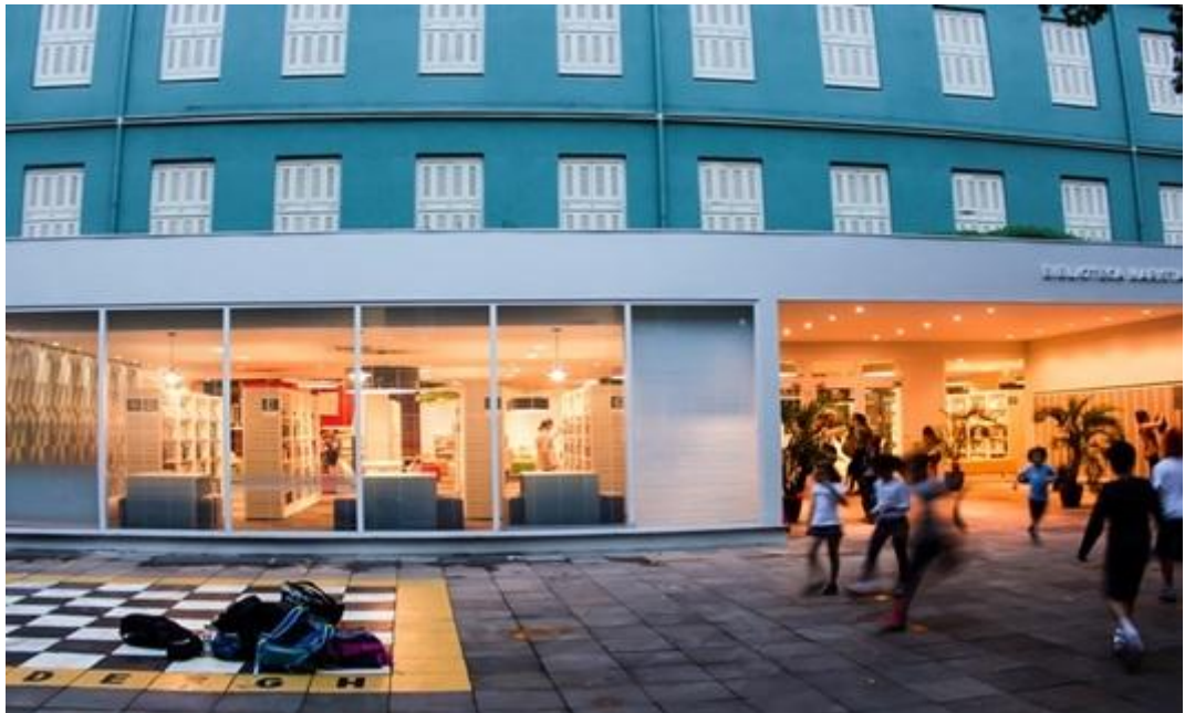
Foto2 –Acesso Principal da Biblioteca após a Reforma
