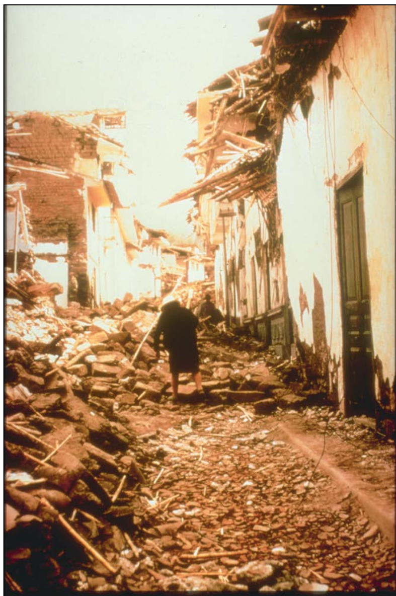
Figura 13 – Danos causados em residências de adobe como efeito do terremoto de maio de 1970 numa rua da cidade de Huaraz [Fonte: National Oceanic and Atmospheric Administration – NOAA / National Geophysical Data Center – NGDC ].
