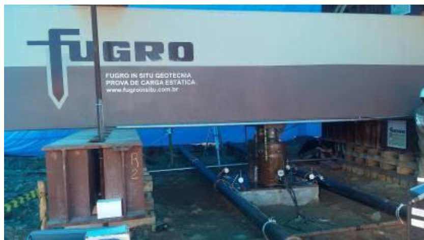
Figura 3.11: Sistema de reação da prova de carga
