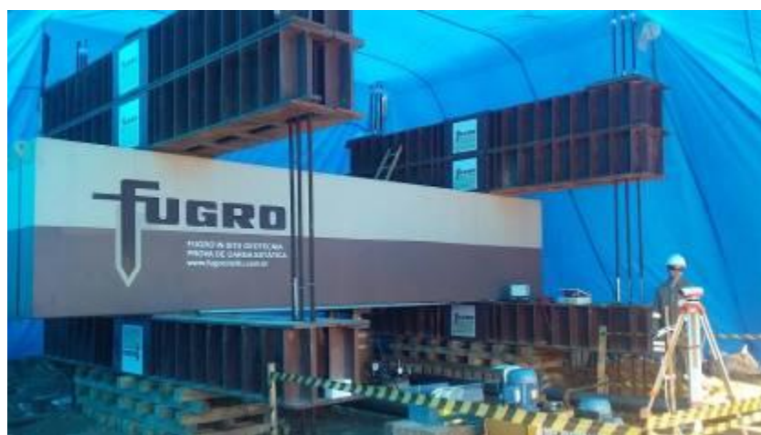
Figura 3.10: Sistema de reação da prova de carga
