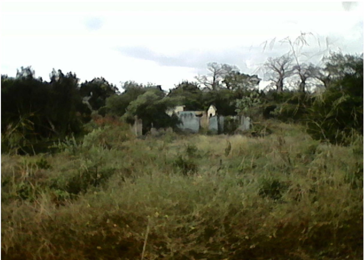
Figura 10: Destroços do antigo centro de saúde de Chipanga, hospital usado pela população antes do reassentamento.
