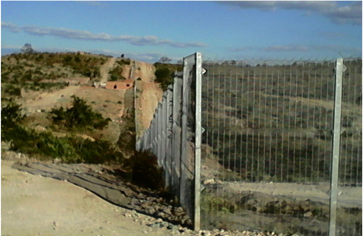
Figura 12: Vista parcial da rede de vedação que separa a zona de concessão da empresa Vale à zona habitacional em Moatize.
