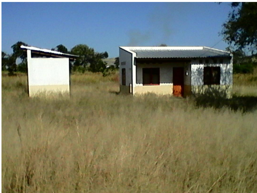
Figura 25: Casa abandonada na comunidade de Cateme.
