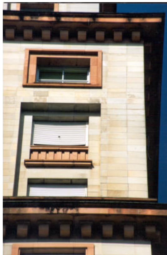
Fig. 4.39 Plataformas horizontais que possibilitam o descolamento da água escorrida - ed. Sulacap
