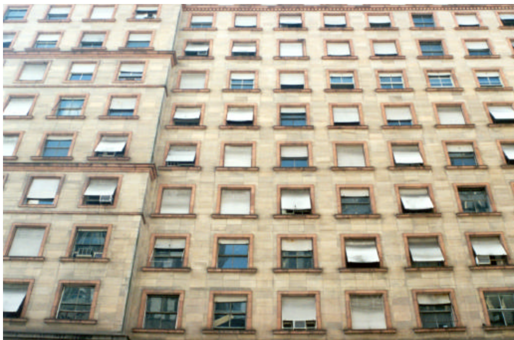
Figura 4.42 Distribuição regular das janelas emolduradas – ed. Sulacap
