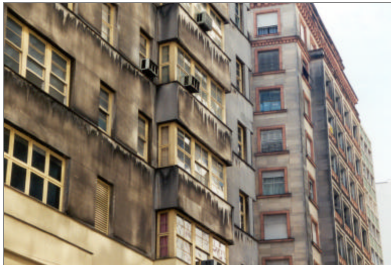
Figura 4.21 Vista dos edifícios Vera Cruz e Sulacap, da Rua Gal. Andrade Neves
