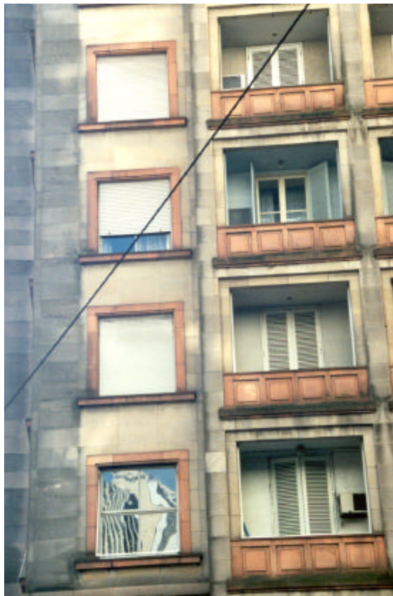
Figura 4.43 Proteção dos parapeitos – efeito de abrigo – ed. Sulacap
