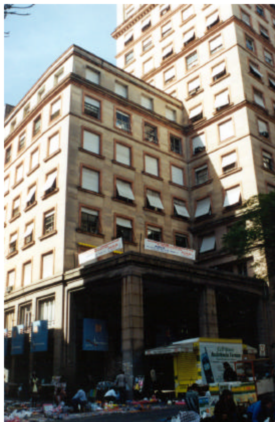
Figura 4.41 Aberturas distribuídas de forma regular – ed. Sulacap
