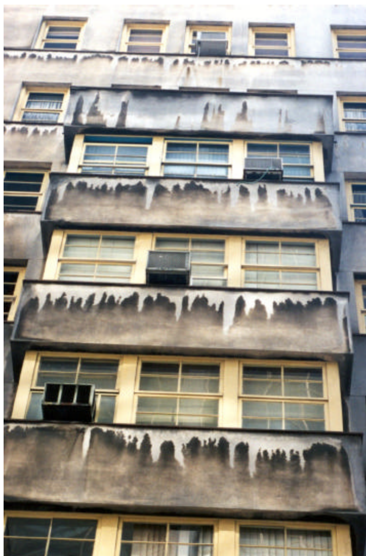
Figura 4.31 Escorrimentos limpos com limites em “dentes de serra”
