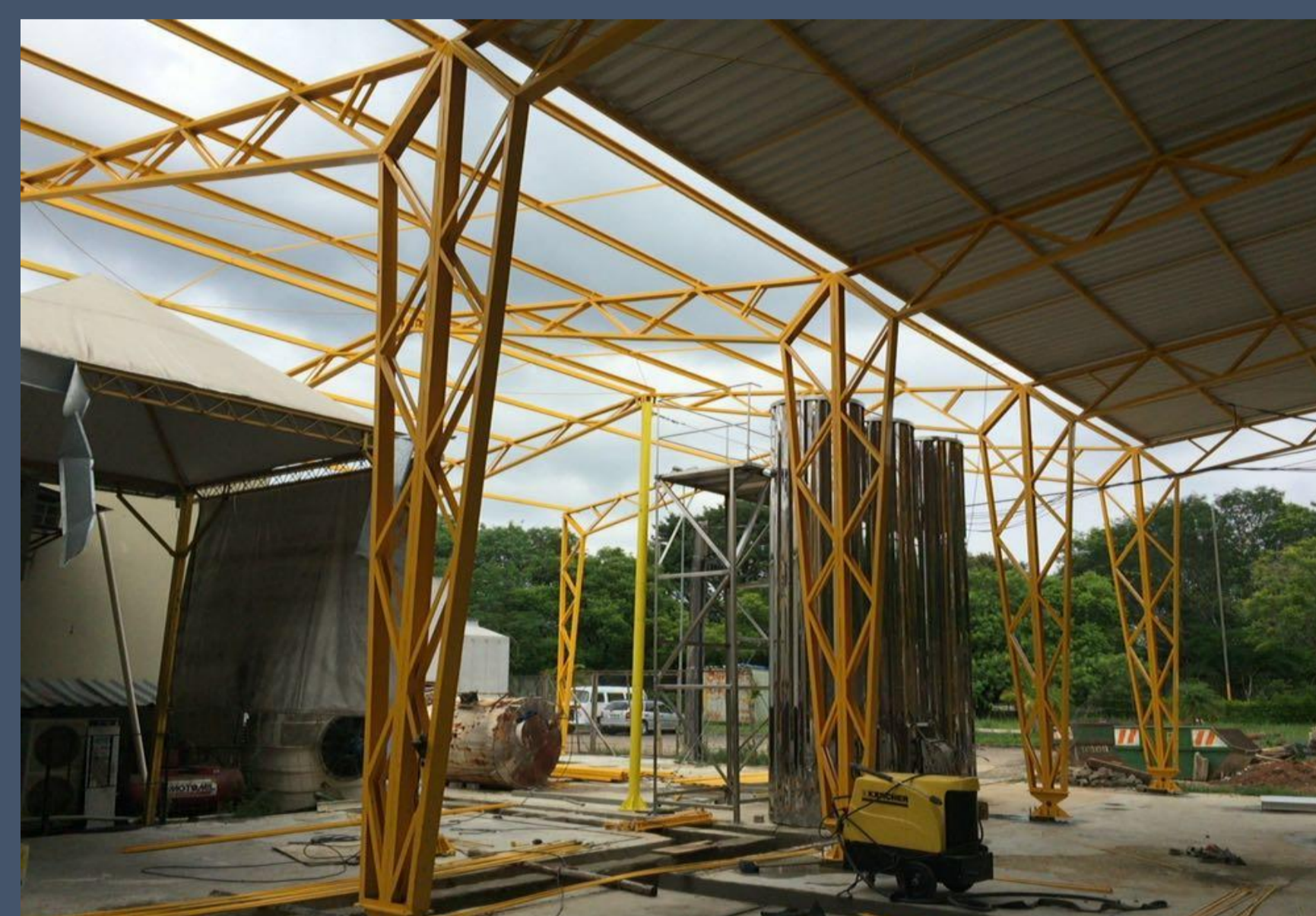
Figura 1 - Pavilhão novo em construção.
