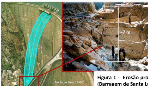
Figura 1 - Erosão provocada por jato (Barragem de Santa Luzia Portugal).
