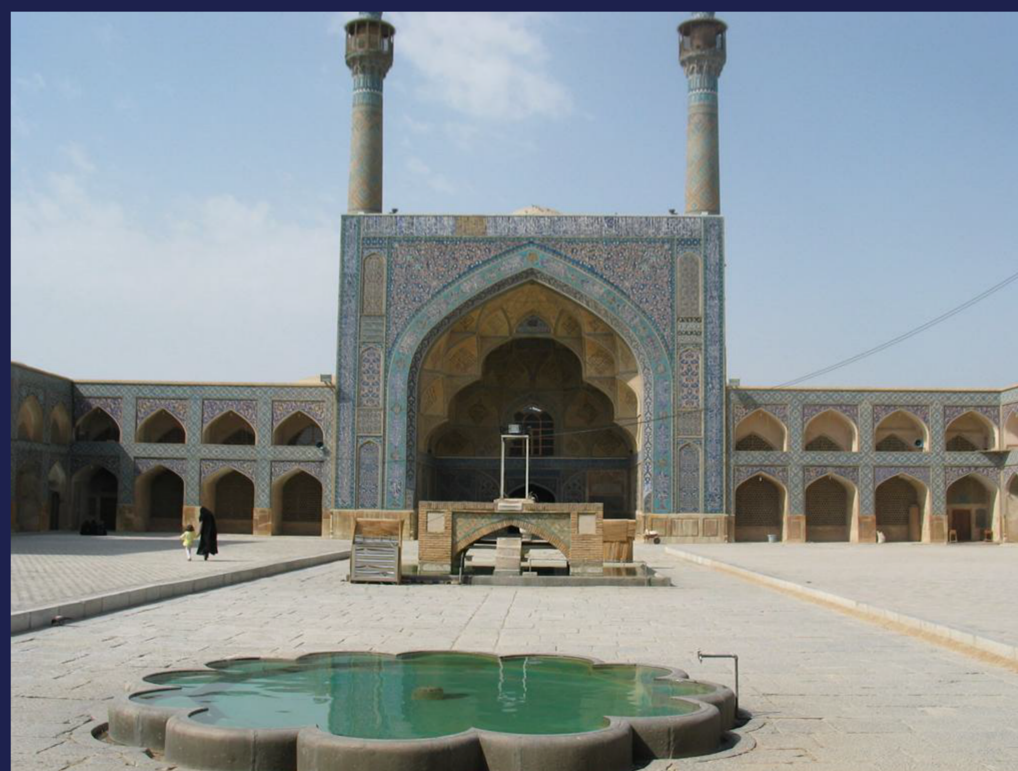
Iwan do pátio interno
