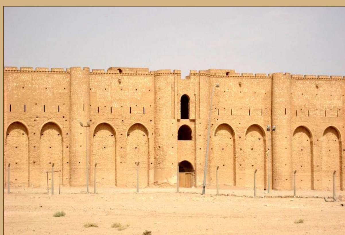
Fig. 3 - Portão sul de Ukhaidir
