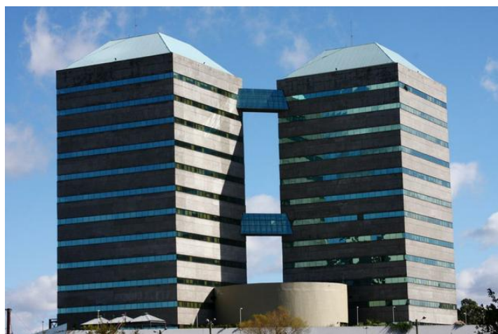
Foto 4: Prédio do Ministério Público, na avenida Aureliano de Figueiredo Pinto, número 80 em Porto Alegre.
